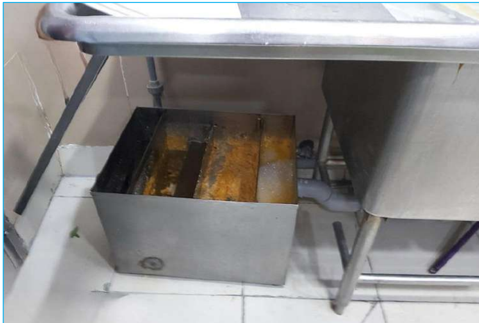
Hình 3.4. Hình ảnh thiết bị tách dầu mỡ
