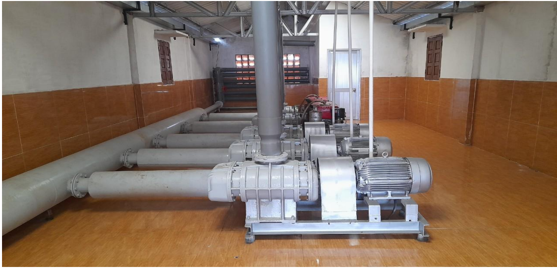
Hình 2.8. Hệ thống máy khí luân phiên đẳng áp sử dụng biến tần hãng INVT
