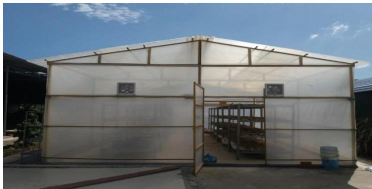
Nhà sấy sử dụng năng lượng mặt trời
