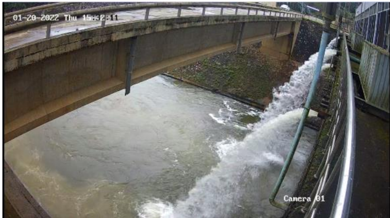
Hầu hết các công trình khai thác, sử dụng nước đã thực hiện lắp đặt thiết bị quan trắc, giám sát tài nguyên nước theo quy định tại Thông tư số 17/2021/TT BTNMT
